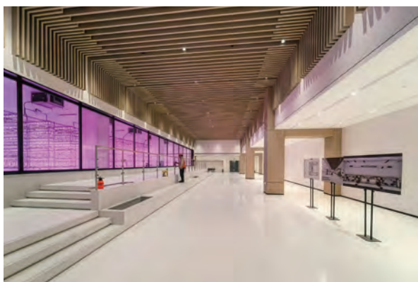
4F - 애터미 오롯 스마트팜 공사현장
